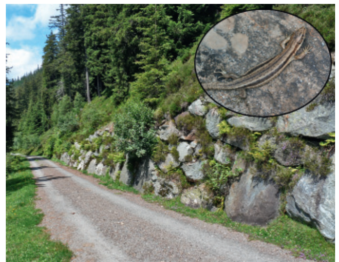
Les talus situés le long des routes forestières et stabilisés par des enrochements ou des gabions offrent aux reptiles des sites d'insolation et des refuges (fig. 4).
