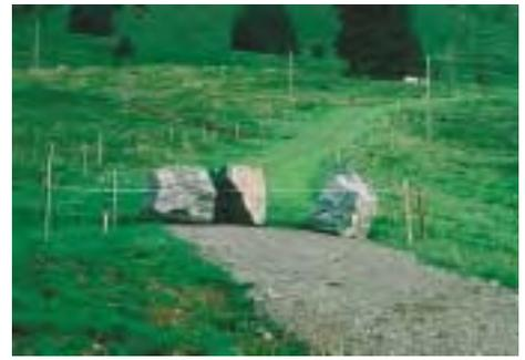
Schutzmassnahme während der Betriebsphase: Steinblöcke verhindern, dass Unbefugte den nur periodisch benutzten Maschinenweg mit Motorfahrzeugen befahren. Bei den periodischen forstlichen Eingriffen wird ohnehin schweres Gerät verwendet, mit welchem die Hindernisse vorübergehend entfernt werden können.
