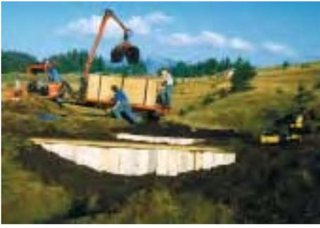
**Hochmoor-Regeneration:** Ein Hochmoor bei Sörenberg (Kt. LU) wird mittels Stau-elementen hydrologisch regeneriert. Es handelt sich um eine Ersatzmassnahme im Zusammenhang mit militärischen Nutzungen. Arbeiten im Bereich wertvoller und empfindlicher Biotope erfordern besondere Sachkenntnisse. Der Beizug einer ökologischen Baubegleitung ist dabei von höchster Bedeutung.
