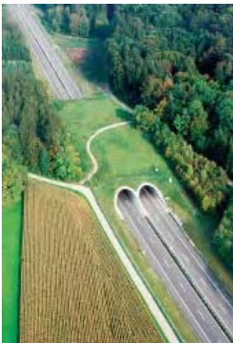
Überdeckung Fuchswies bei Neuwil (Kt. TG): Die A7 zerschneidet den ganzen Hügelzug zwischen dem Thurtal und dem Bodensee. An denjenigen Stellen, wo die A7 zusammenhängende Waldgebiete quert, wurden auf Vorschlag des Tiefbauamtes Grünbrücken erstellt. Derartige Ökobridgen vermindern den Zerschneidungseffekt der Strasse. In der intensiv genutzten Landschaft stellen sie gleichzeitig wertvolle Lebensräume für geschützte oder seltene Arten dar.
