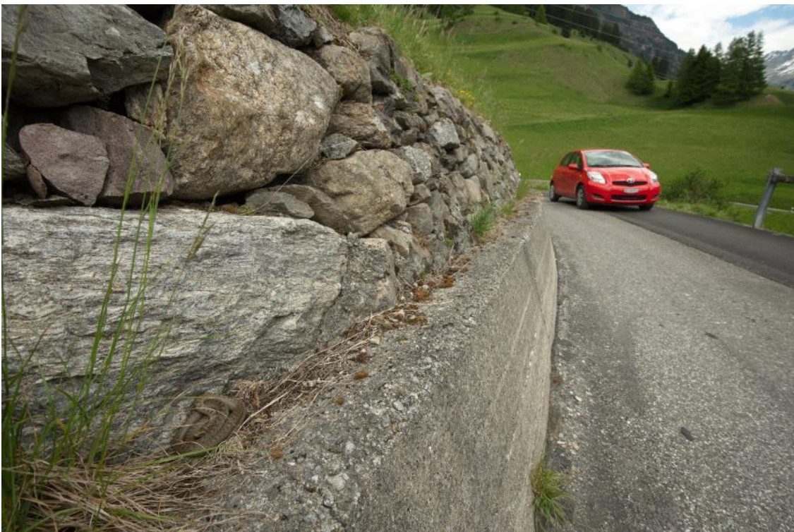
Auch Trockenmauern entlang von Strassen, Wegen oder Bahnlinien werden von Reptilien besiedelt. Der Verkehr stellt in der Regel kein Problem dar. Selbst entlang von stark befahrenen Verkehrswegen finden sich Reptilien. Auf dem unteren Bild zu sehen eine Schlingnatter ( Coronella austriaca ) beim Sonnenbad direkt an einer Landstrasse. (Fotos: ANDREAS MEYER)
