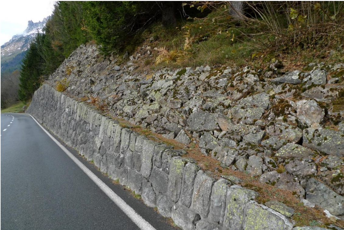
Eine besondere Form von Trockenmauerwerk sind sogenannte Rollierungen, schrägstehende Stützmauern in Trockenbauweise oberhalb oder unterhalb von Strassen oder Eisenbahnliesen. Rollierungen werden sehr gerne von verschiedenen Reptilienarten besiedelt, und oft stellen sie Winterquartiere dar. (Fotos: ANDREAS MEYER)
