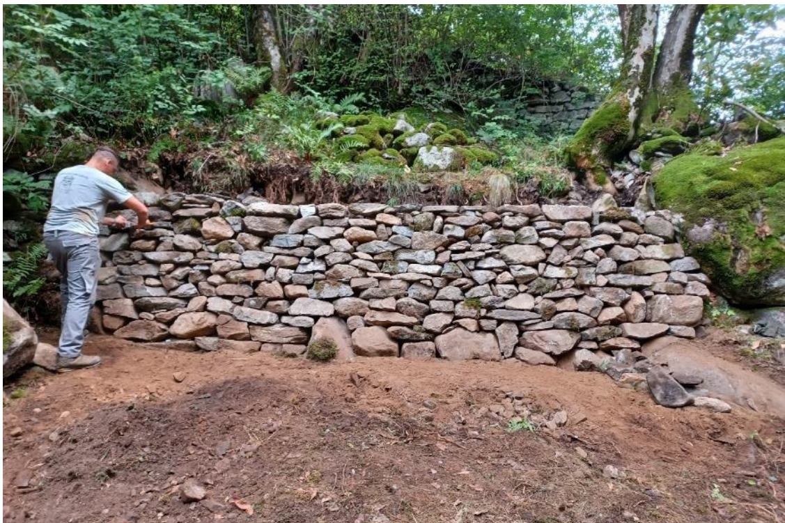
Kleinräumige Sanierung einer Trockenmauer im Tessin: Der traditionelle Unterhalt der Mauer ist für Reptilien unproblematisch, wenn die Arbeiten nur wo nötig, an schadhaften Stellen ausgeführt werden. Problematisch ist die Sanierung ganzer Netzwerke von Mauern innert kurzer Zeit. (Fotos: STEFAN MEIER)
