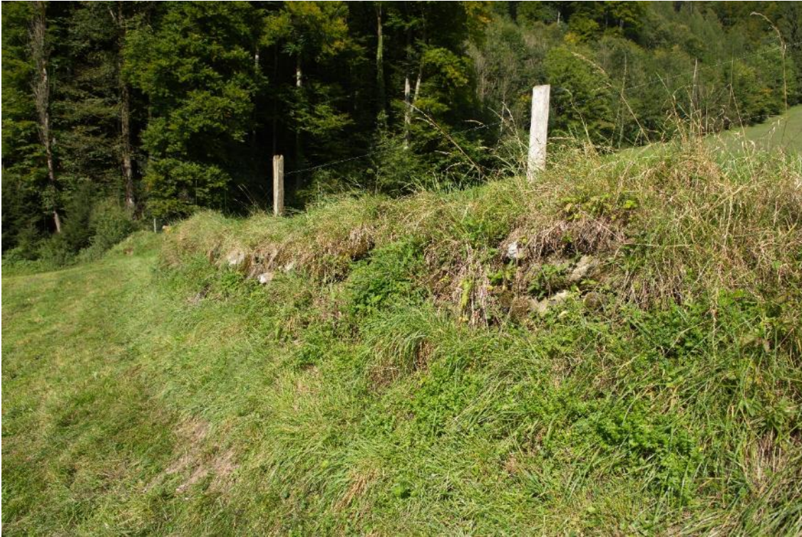
Gras- und Krautsäume entlang von Trockenmauern dürfen sehr ausgeprägt sein; die Mauern bleiben für Reptilien attraktiv. Zu vermeiden ist aber, dass das Mauerwerk durch Gehölze oder Bäume zu stark beschattet wird. (Foto: ANDREAS MEYER)
