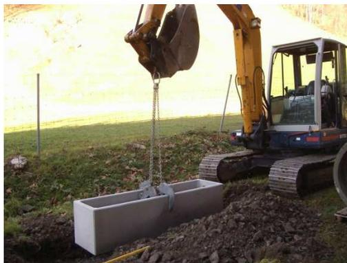
Abb. 22: Eingraben eines Betontröges,
