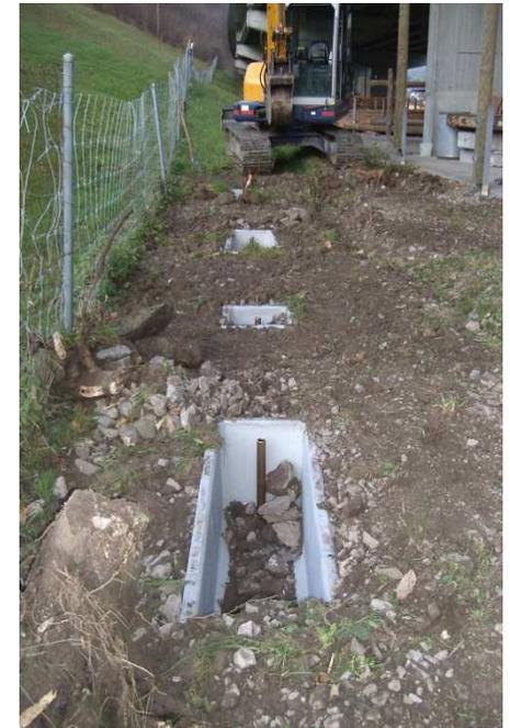
Abb. 20: Fertig eingegrabene Betontröge,
