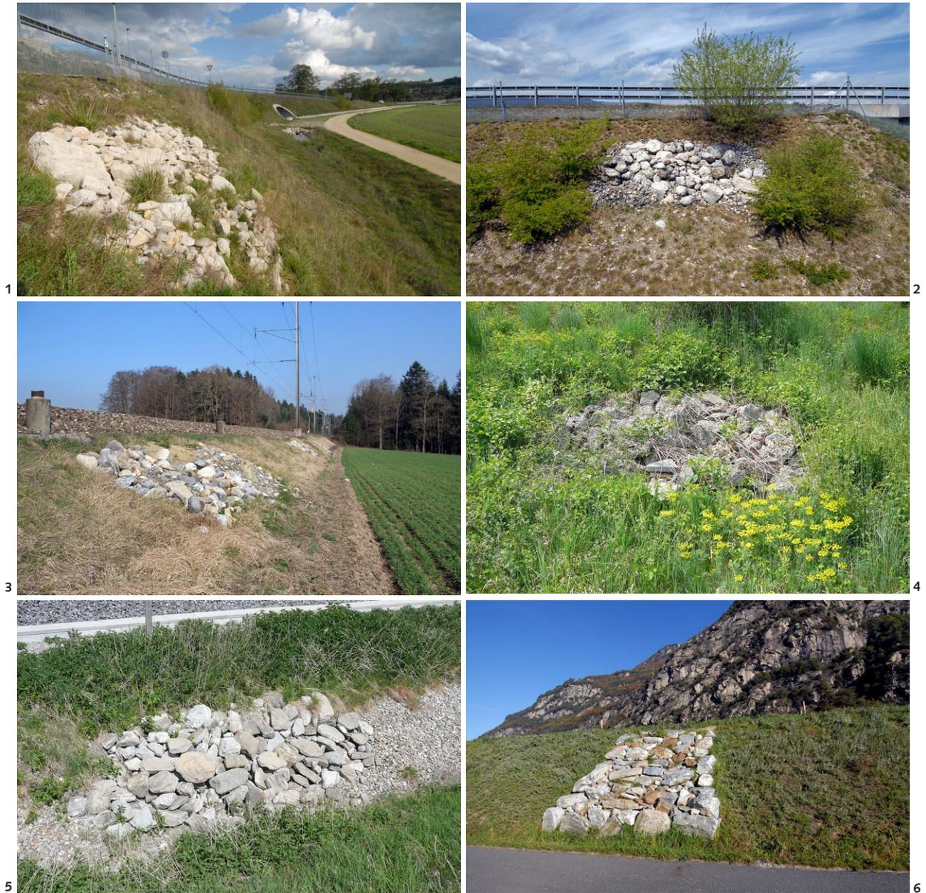
**Fig. 1** Ottimo esempio di nicchia di rocce in una scarpata lungo un'autostrada nel Giura meridionale. Le pietre calcaree grezze utilizzate hanno una dimensione appropriata. Come si può notare, sono state utilizzate pietre di diverse dimensioni che oltretutto si integrano in maniera ottimale con la vegetazione, offrendo ai rettili posti al sole e numerosi nascondigli. (AM)
