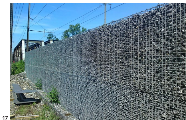
Fig. 13 Esempio di gabbioni lungo una scarpata stradale, questa costruzione è favorevole alle lucertole. (AM)
