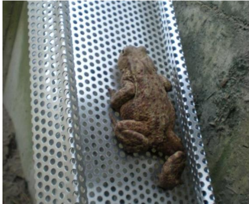
Figure 3. Crapaud commun sur une rampe de sortie. Les bords sont repliés afin de conduire les animaux et la rampe est perforée afin d'augmenter leur adhérence. source (Siegl M. et Landmann A., 2012).
