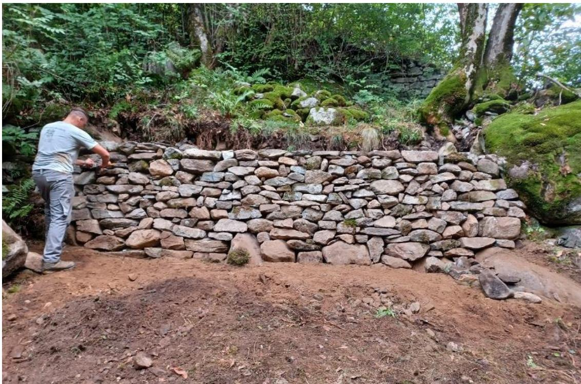
*Restauro su piccola scala di un muro a secco in Ticino: la manutenzione tradizionale dei muri non è problematica per i rettili se i lavori vengono eseguiti solo dove necessario, nelle aree danneggiate. La ristrutturazione di intere reti di muri in un breve periodo di tempo è invece problematica. (Foto: STEFAN MEIER)*
