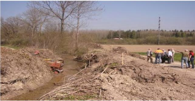
Foto 1. Der 120-jährige Damm des Hüttlinger Dorfbaches musste saniert werden, da der Biber durch das Anlegen von Erdbauten seine Stabilität gefährdete.
