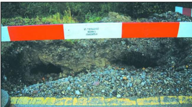
Foto 3. Zwischen Müllheim und Pfylen wird die Staatsstrasse immer wieder vom Biber unterhöhlt und bricht ein. Hier müssen zwei nebeneinanderliegende Erdbauten aufgefüllt und die Strasse saniert werden. Ein Absperren des Augrabens für den Biber blieb bisher erfolglos.
