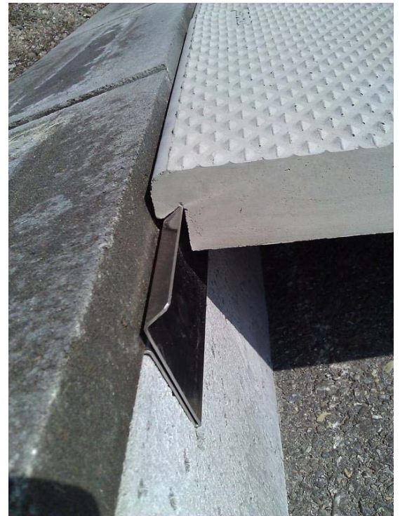
Abbildung 15: Detailansicht der Klammer mit eingehängter Rampe.
