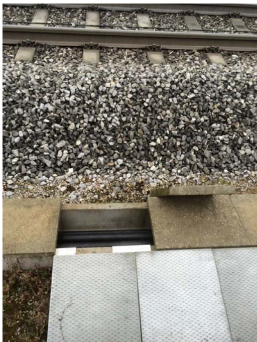
Abbildung 20: Rampen bei Grafenried; Sicht auf Schotter und Gleise.
