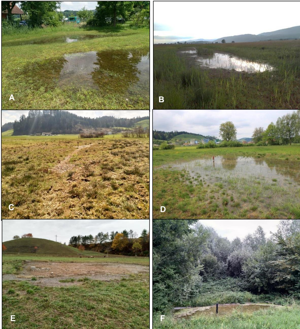
Abb.1: Verschiedene Erstellungsarten von Flutmulden. A: Lehmsenken mit Ablassvorrichtung; B: Bentonitabdichtung mit Solarpumpe; C & D: Flutmulde mit einstaubarem Drainagesystem; E: Folienweiher mit Ablassvorrichtung; F: Folien-Betonweiher ohne Überdeckung mit Ablasssystem. (Foto D von Priska Stricker).
