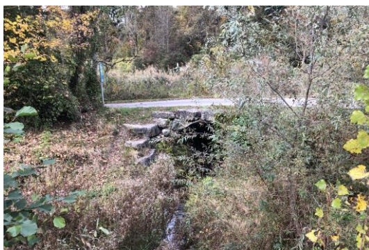
fig. 13 : La vue d'ensemble du pont.
