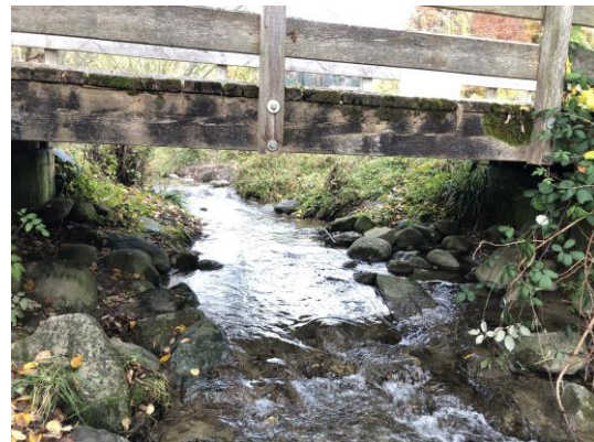
fig. 18 : Détail sous le pont avec des accotements.
