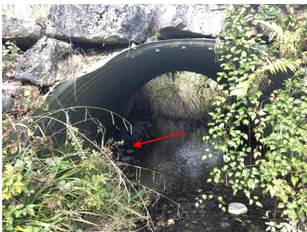
fig. 9 : Tuyau en métal ondulé servant de ponceau sous un chemin avec un accotement de pierres et de boue.
