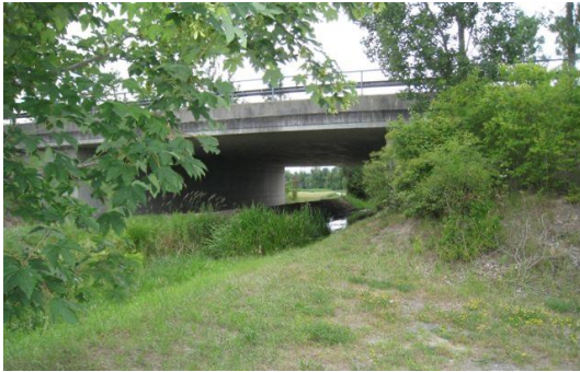
fig. 15 : La vue d'ensemble du pont.
