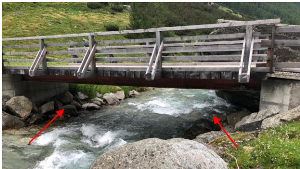
fig. 7 : Pont sur un ruisseau de montagne avec de grandes pierres des deux côtés.
