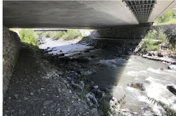
fig. 12 : Pont relativement bas sur une route cantonale avec des accotements surélevés des deux côtés.
