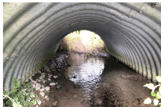
fig. 14 : Détail sous le pont avec des banquettes.
