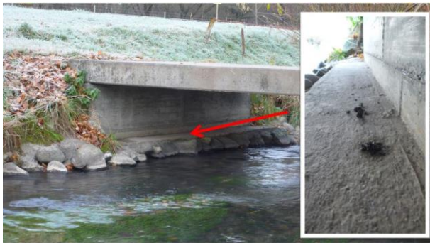
fig. 5 : Pont avec accotement bétonnée unilatérale.
