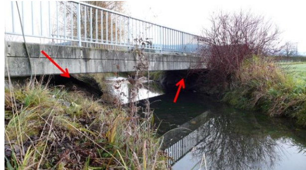
fig. 6 : Pont avec un accotement en pierre et en terre des deux côtés.
