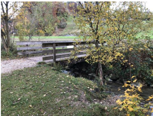
fig. 17 : La vue d'ensemble du pont.
