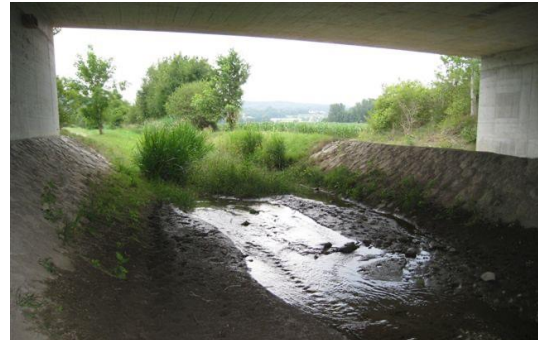
fig. 16 : Détail sous le pont avec des accotements.
