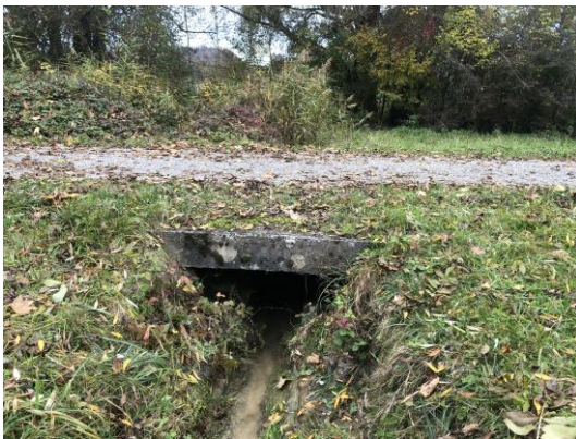
fig. 19 : La vue d'ensemble du pont.
