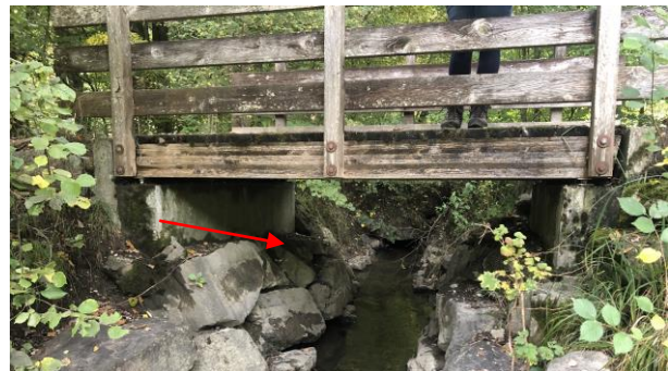
fig. 8 : Pont piétonnier avec de grosses pierres et de la terre des deux côtés.
