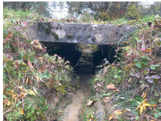
fig. 20 : Détail sous le pont avec des accotements.
