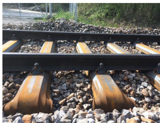
Dank einer tiefen Planung des Schotters können Amphibien, zwischen Gleiskörper und Schotter durchwandern. (© Oliver Dosch)
