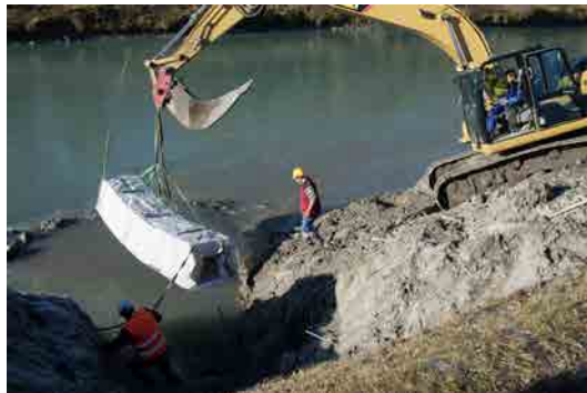
Abb. 1: Einbau eines Kunstbaus an Stelle des besetzten Hauptbaus im Biberrevier.
