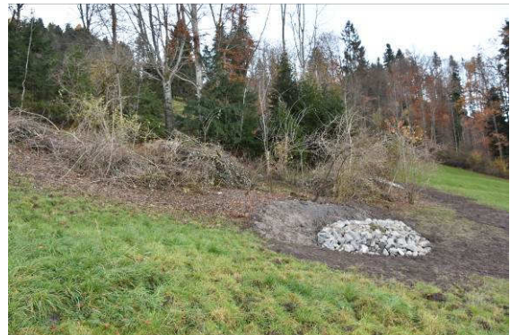
Im Gebiet Schlagweiher, Kriens, konnten auch grosszügige Lebensräume gestaltet werden (Foto: Andreas Tschopp)
