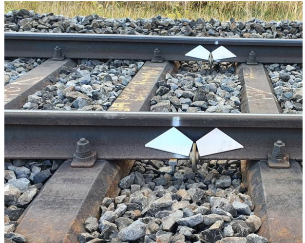
Tronçon à une voie où le ballast est abaissé toutes les 11 ou 12 traverses. Traverses en acier.
