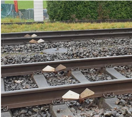
Tronçon à deux voies où le ballast est abaissé toutes les 15 traverses. Traverses en béton.
