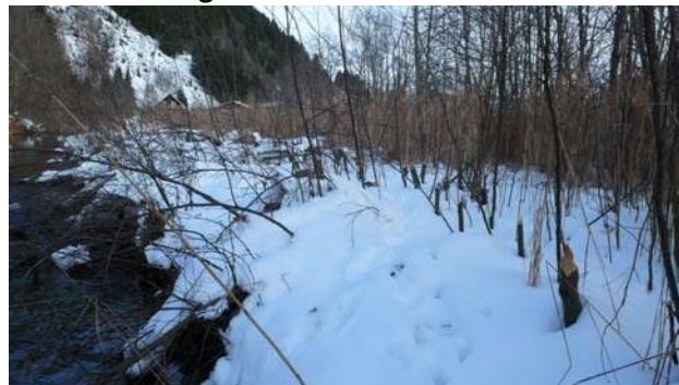
Chantier long de 30 m et large de 5 m avec des saules d'env. 5 cm de diamètre.
