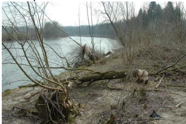
Chantier long d'environ 50 m sur la berge d'un grand cours d'eau.
