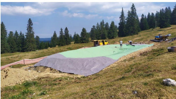
e. Abdichtung (Folie zwischen zwei Vlies-Schichten)
