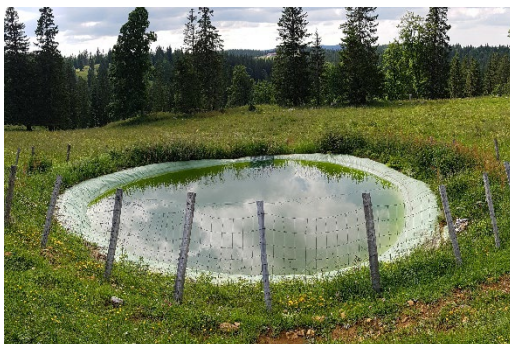
Abbildung 3. Becken, dessen Abdichtung durch eine freiliegende Folie gewährleistet wird (Le Mazel, Montriche, VD).
