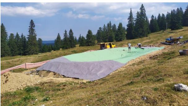
e. Imperméabilité (bâche entre deux géotextiles)
