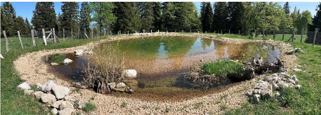
Figure 1. L'étang agroécologique de la Correntine (Bière, VD) six ans après sa construction. D'une capacité de rétention de 150 m<sup>3</sup>, il sécurise l'approvisionnement en eau de deux alpages voisins. Il accueille par ailleurs une diversité biologique remarquable à l'échelle régionale (flore, batraciens et libellules).
