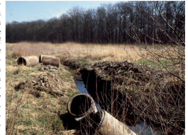
Rückbau von Verrohrung zur Optimierung von Larvengewässern
