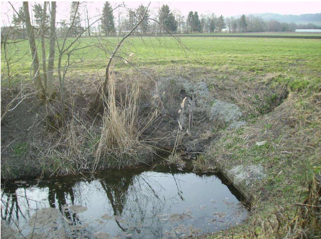
**Abb. 10:** *Durch Erdbau verursachter Böschungsabrutsch am Halemattenkanal, März 2009. Die Funktion des Kanals und der hier mündenden Drainagen wird dadurch längerfristig beeinträchtigt.*
