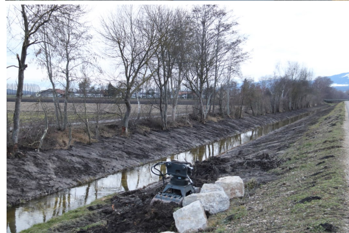
Ci-dessus 2 vues des travaux : la rive droite est décapée, la terre est entreposée sur la rive gauche avec les blocs de pierres qui serviront à maintenir le treillis en place. Celui-ci est posé sur une largeur de 3m.
