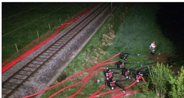
**Illustration 8** – l'eau de l'étang de castor est pompée par-dessus le remblai ferroviaire. Le niveau de l'eau a presque atteint le lit de ballast (en haut à droite; photo: U. Wegmann, service Conseil Castor de Zurich).
