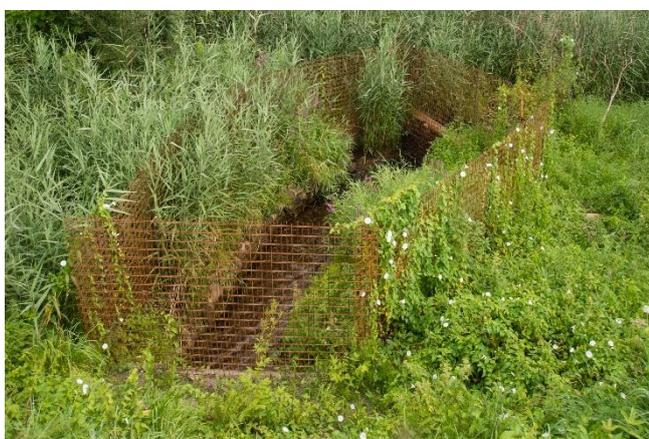
**Illustration 9** – le voûtage du Furtbach sous le remblai ferroviaire est désormais protégé des castors par un système de grillages.
