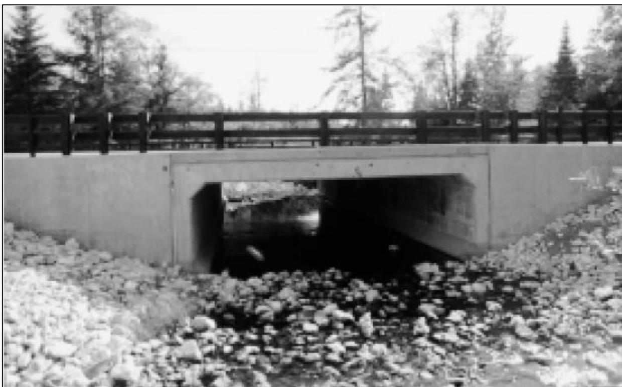
**Illustration A6\_2** – section transversale plate et rectangulaire pour un passage de cours d'eau.
