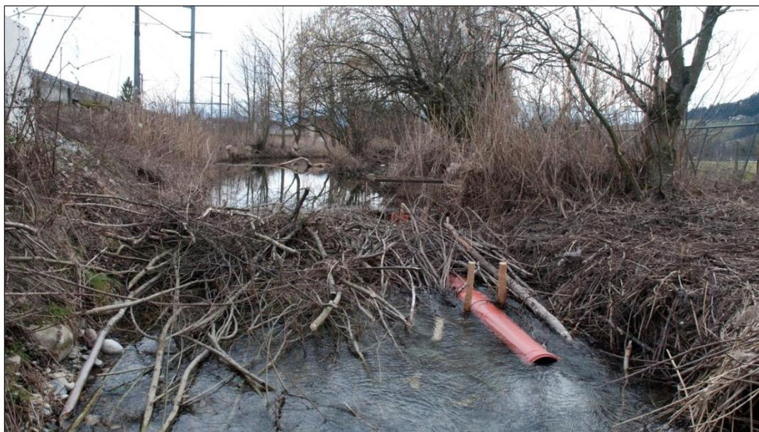
**Illustration 6** – barrage de castor drainé au moyen d'un tube sur un remblai des CFF à Münsingen. Le niveau de l'eau a ainsi pu être ramené provisoirement à une hauteur acceptable.
