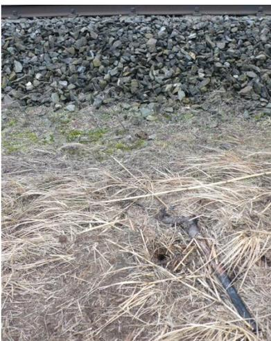
Trou d'aération d'un terrier de castor dans le remblai d'une ligne
