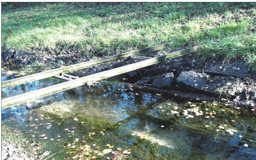
Entrée de terrier dans un canal de drainage. L'entrée se situe en dessous du rail, sous les plantes aquatiques.
