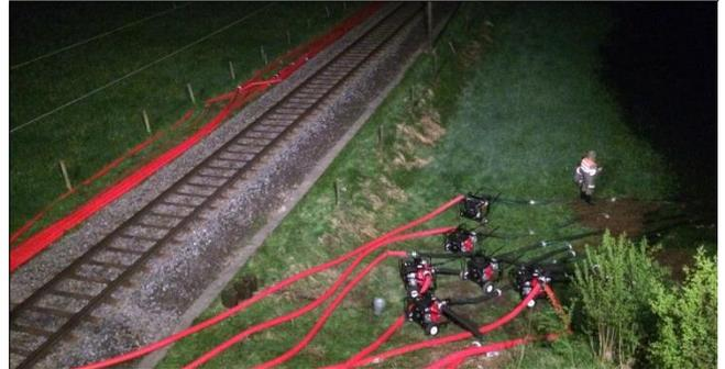
**Abb. 9:** Das Wasser des Bibersees wird mit Pumpen über den Bahndamm abgepumpt. Der Wasserspiegel ist fast auf Höhe des Schotterbettes (oben rechts; Bild U. Wegmann, Biberfachstelle Zürich).
