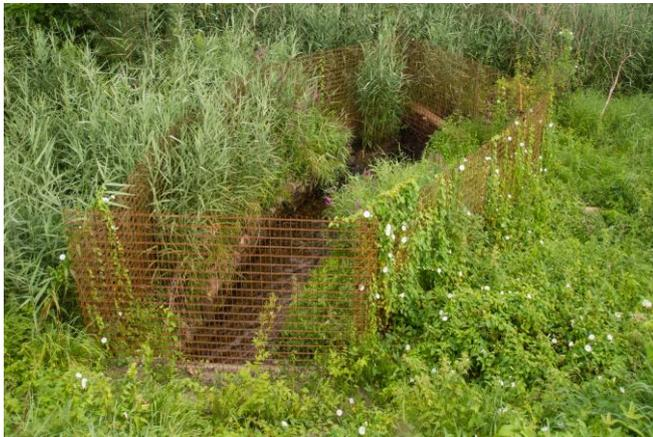
**Abb. 10:** Der Durchlass unter dem Bahndamm am Furtbach ist mit einer grossen Installation bibersicher vergittert worden.
