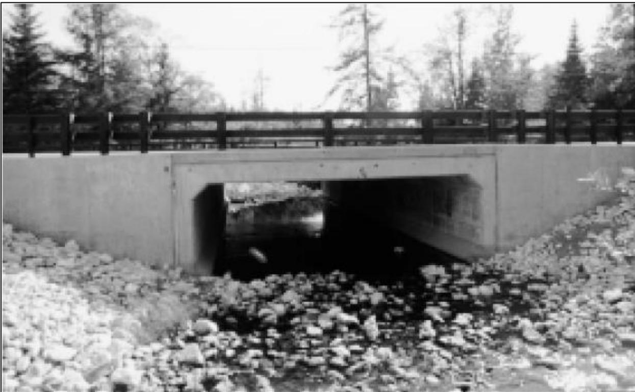
Abb. A7\_2: Flaches, rechteckiges Querschnittprofil für Durchlässe.
