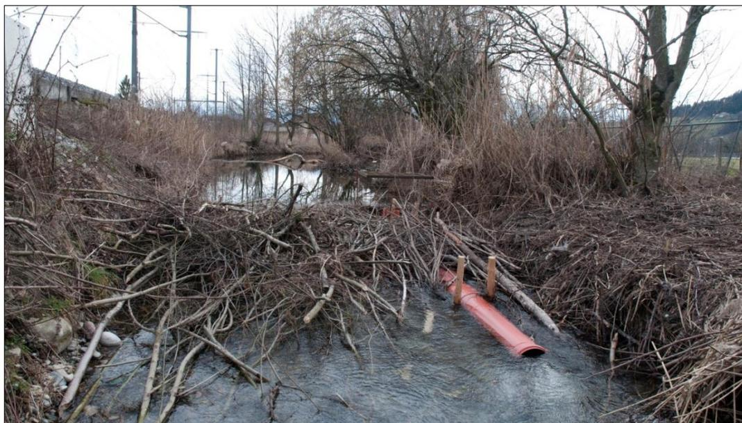
**Abb. 7:** Mit einem Rohr drainierter Biberdamm am SBB-Bahndamm in Münsingen. Der Wasserspiegel konnte so zwischenzeitlich auf eine tolerierbare Höhe gesenkt werden.
