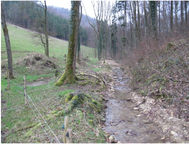
Abb 6: Bei Hochwasser fließt das Wasser durch den Überlauf in die 2014 aufgewertete Bachaue Chatzenstieg in Effingen und füllt die 4 neu ausgehobenen Tümpel. Im unteren Bereich fließt das Wasser zurück in das Hauptgerinne.
