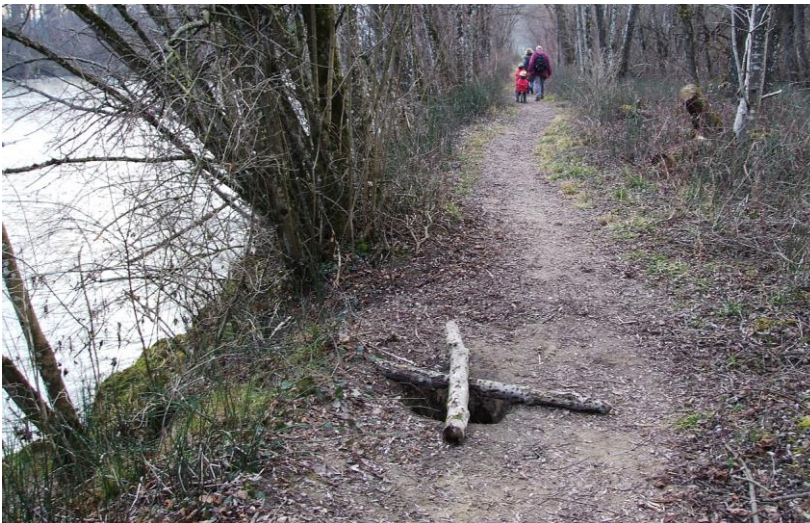
Eingestürzter, verlassener Erdbau unter einem Pfad.
