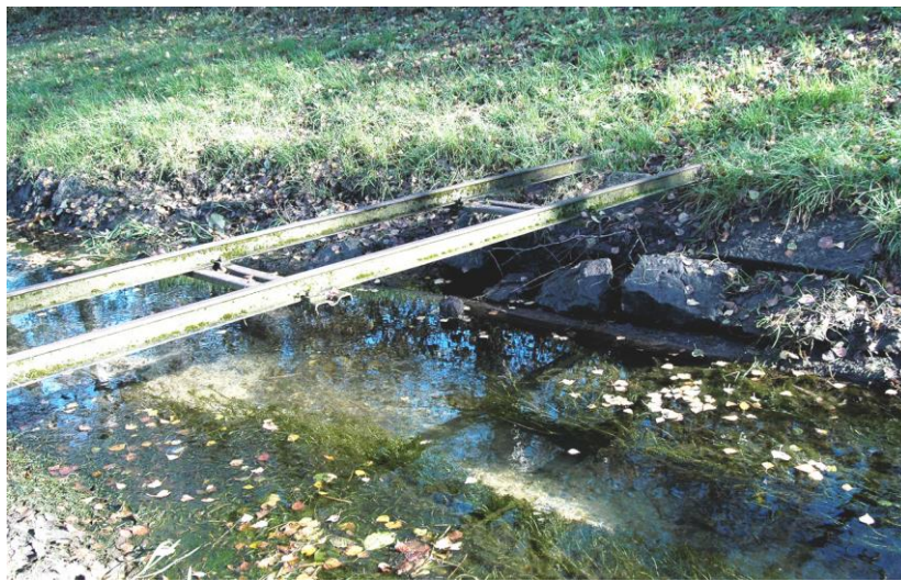
Baueingang in einem Entwässerungsgraben. Der Eingang befindet sich unterhalb der Schiene unter den Wasserpflanzen.
