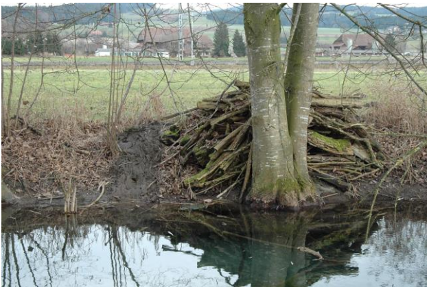
Ausstieg um das eingestürzte Dach des Erdbaus zu flicken. Der Eingang zum Bau befindet sich unter dem Baum.
