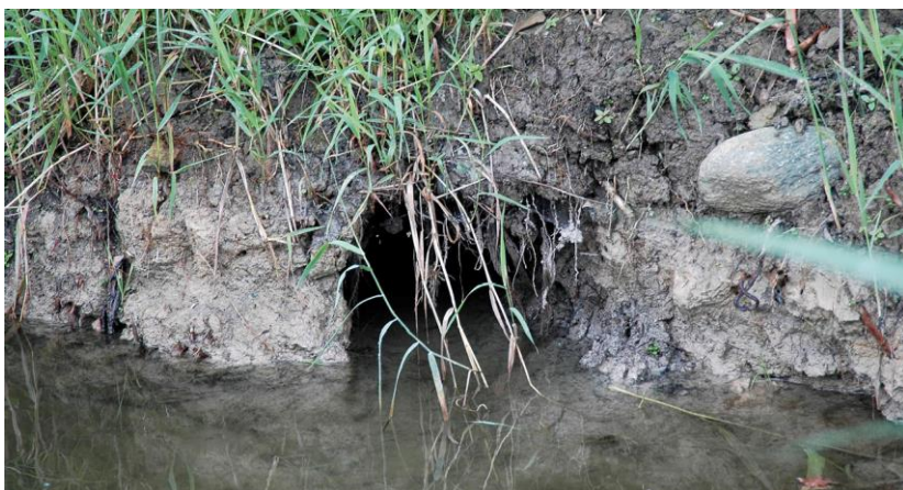
Baueingang an einem Kanal bei Niedrigwasser.
