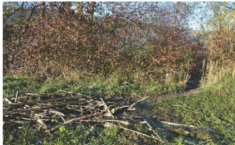
Eingestürzter Erdbau. Das Dach wurde mit Ästen zugedeckt. rechts: Ausstieg für Reparaturarbeiten.
