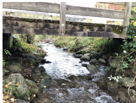
Abb. 18: Detail unter der Brücke mit beiden Banketten.
