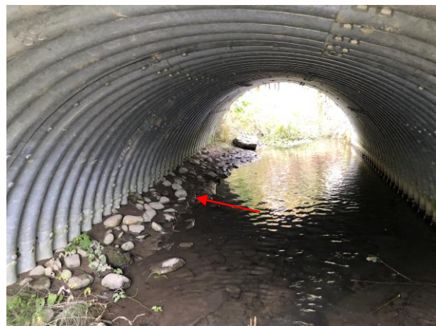
Abb. 10: Wellblechrohr. Markiermöglichkeiten auf dem Bankett aus Steinen links.
