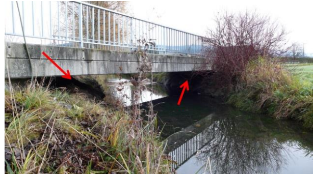
Abb. 6: Brücke mit beidseitigem Bankett aus Steinen und Erde.
