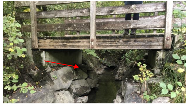
Abb. 8: Fussgängerbrücke mit beidseitigen Banketten aus grossen Steinen und Erde.
