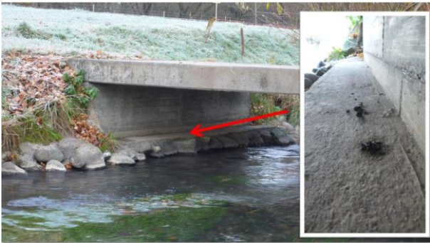
Abb. 5: Brücke mit einseitig betoniertem Bankett.
