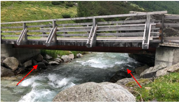
Abb. 7: Brücke über einen Bergbach mit beidseitig grossen Steinen.
