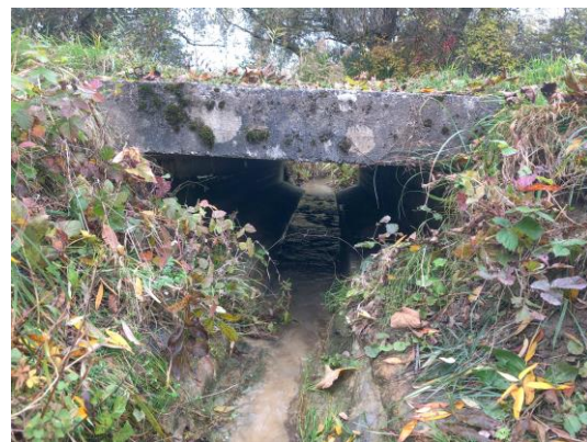
Abb. 20: Detail unter der Brücke mit beiden Banketten.
