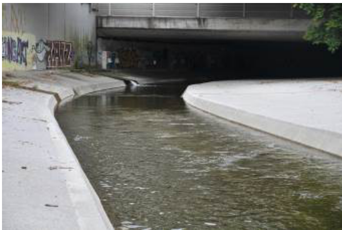
Foto 1. Die Töss bei Winterthur vor der Autobahntunnelunterquerung bei der Rieter AG. Bei Normalwasserführung kann ein Biber auf einer Strecke von 450 Meter Länge nicht aus dem Wasser auf die Betonsohle klettern.
