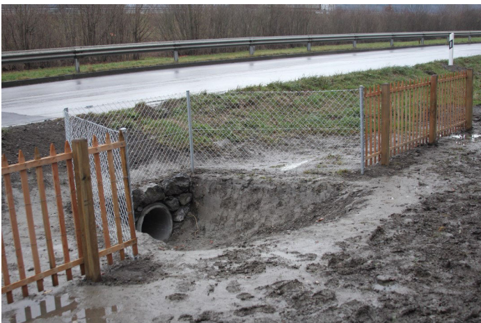
Des barrières orientent les castors vers le passage sécurisé et des pièges photos ont été posés pour immortaliser les premiers castors à emprunter la passe à castor du Duzillet !
