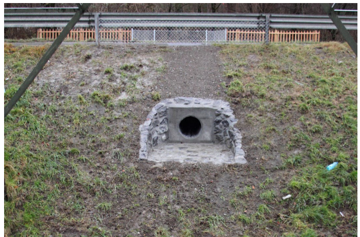
Des barrières orientent les castors vers le passage sécurisé et des pièges photos ont été posés pour immortaliser les premiers castors à emprunter la passe à castor du Duzillet !
