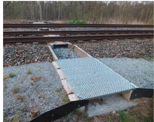
Abbildung 4: Eingebaute Passage in den Niederlanden, im Vordergrund sind die zuweisenden Elemente sichtbar © Movares
