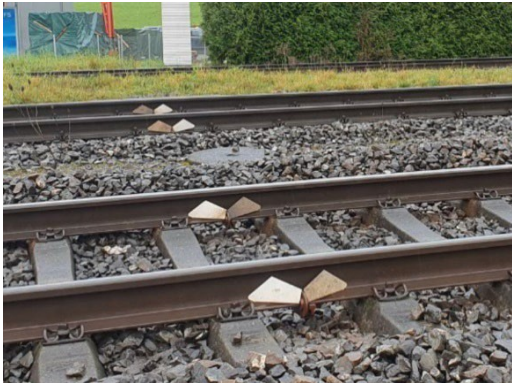
Abbildung 1: Installierte Amphibienableitbleiche
