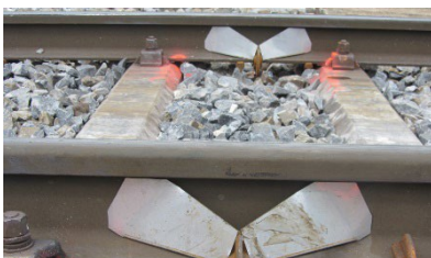
Abbildung 5: Installierte Amphibienableitbleiche
