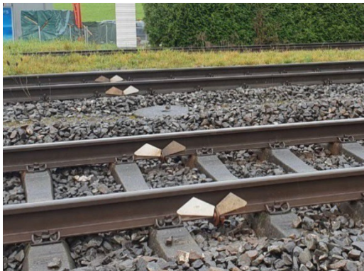
Illustration 1 : déflecteurs de voie installés © UTP
