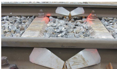
Illustration 5 : déflecteurs de voie installés © S. Suter
