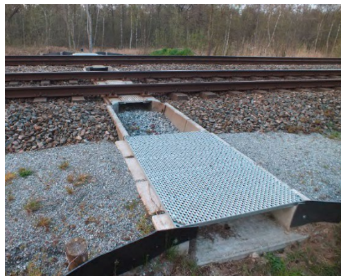
Illustration 4 : passage intégré aux Pays-Bas, les éléments de guidage sont visibles au premier plan © Movares
