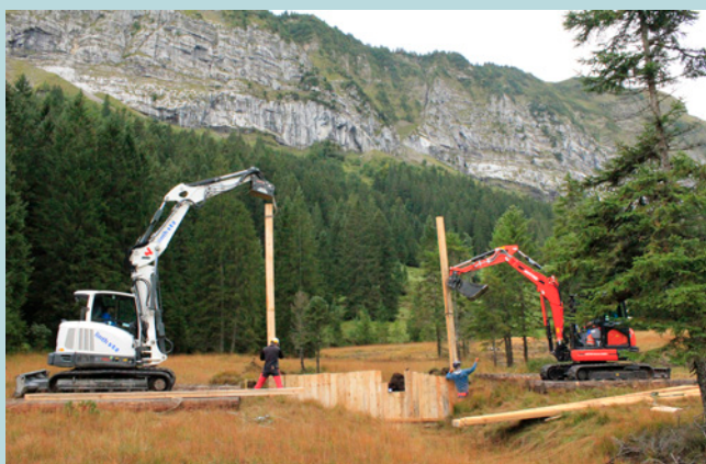
Abb. 42. Errichtung einer Holzspundwand in einem Hauptentwässerungsgraben (Hochmoor Gross Moos im Schwändital, links). Bereits nach weniger als drei Jahren nach den Renaturierungsarbeiten am «Etang de la Gruère» wachsen Torfmoose in und flachmoortypische Arten an Teichen (rechts). (Fotos: links: Lena Gubler; rechts: Angéline Bedolla).
