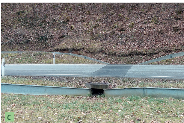
Abb. 4: Exemplarische Darstellung bestimmter problematischer Situationen an Leiteinrichtungen und Querungshilfen aus der Praxis. (a) Stark eingewachsene und schon dadurch nicht mehr funktionale Leitanlage mit Durchlass. (b) Durchlass steht unter Wasser. (c) Zu gering dimensionierter Durchlass bei zugleich problematischer Rückwanderungssituation vor allem für Jungtiere im Hang auf der gegenüberliegenden Straßenseite. (d) An diesem Durchlass wandern nach vorliegenden Beobachtungen viele Amphibien parallel zur Leiteinrichtung vorbei (Fotos: U. Miller, J. Trautner).
